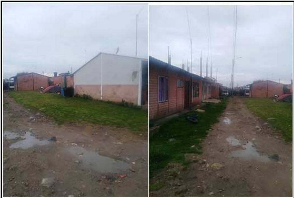
Entrada de 3 metros, para el ingreso de vehículos y paso peatonal, además por la mitad pasan todos los servicios públicos
