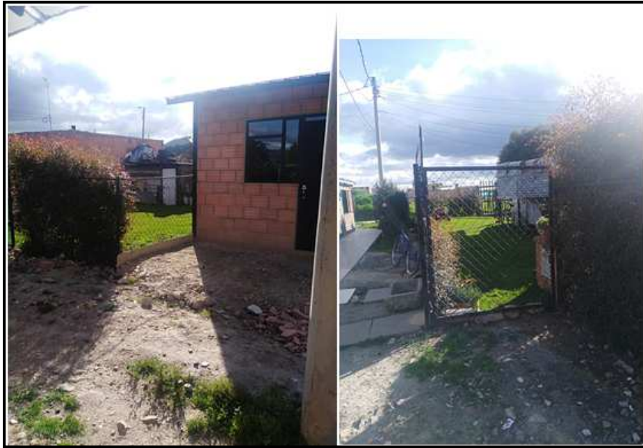
Cerramiento sobre la servidumbre lote 5 en construcción
