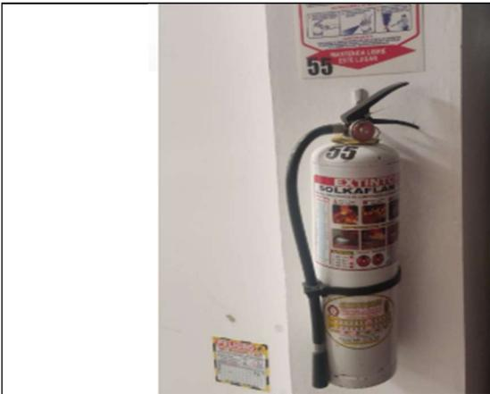
Fotografía no. 56. Extintor solkaflam especial para equipos de computación.
