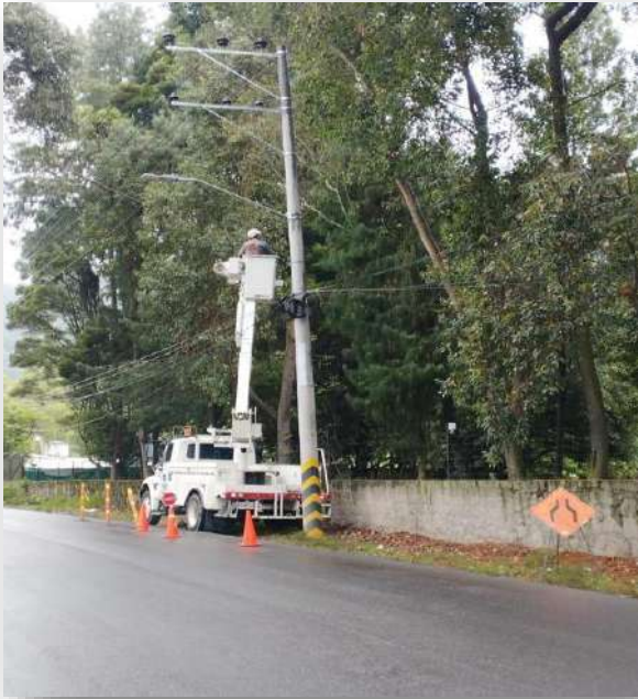
Ilustración 18.Cambio de luminarias
