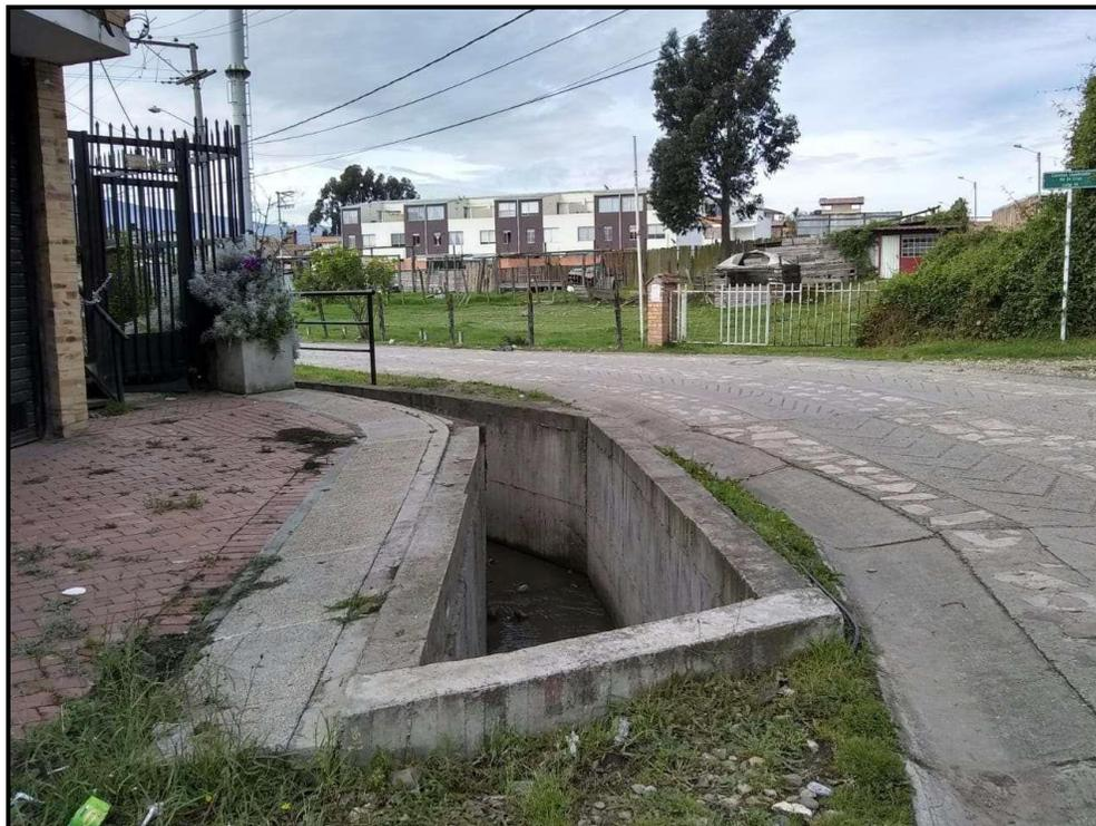
Aguas abajo del box culvert que pasa por debajo del camino de la cruz, se encuentra un canal de sección rectangular el cual conduce el agua por detrás de una construcción hasta desembocar en una sección trapezoidal con recubrimiento vegetal.
