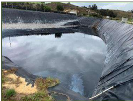
Foto 8. Pozo de bombeo de lixiviados
