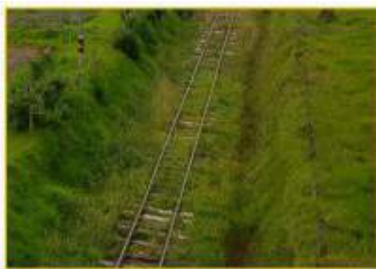
Red vial, ferroviaria y terrenos asociados
