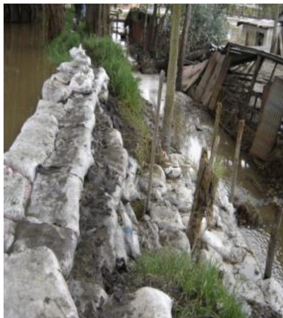
Ilustración 25. Afectación sobre el dique del río Bogotá, vereda Calahorra. Inspección CAR sitios críticos
