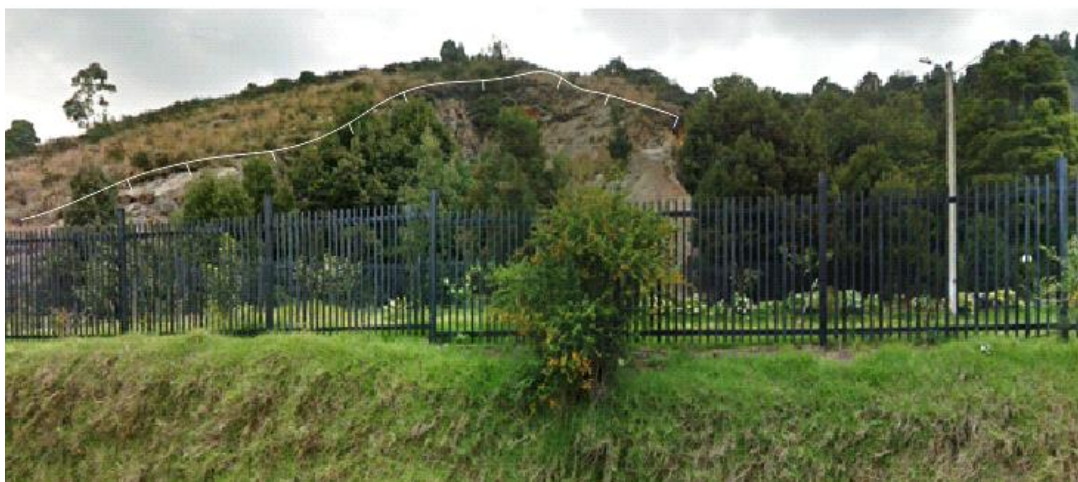
Ilustración 20. Proceso de inestabilidad vía Molino – Manas, Coordenadas X=1005643,5 Y=1038491,1
