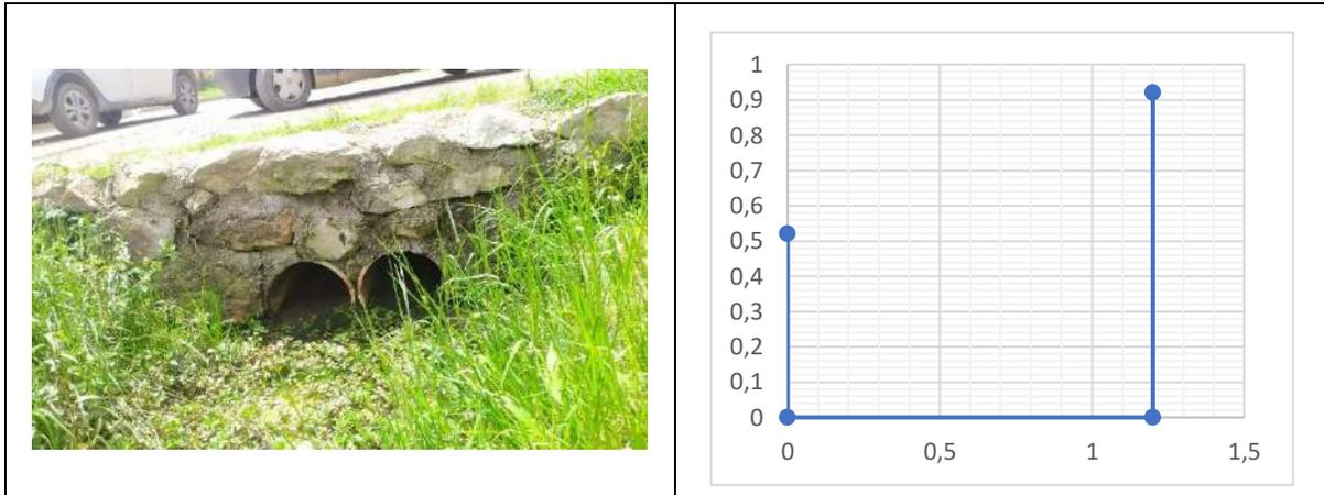
Canal natural de sección rectangular con alturas entre 0.52 a 0.92 m de alto y 1.20 de ancho. La conexión entre vías se lleva a cabo mediante dos ductos de 35 cm de diámetro cada uno. Se evidencia colmatación en el sistema por lo que el canal se encuentra inundado debido a un estancamiento. Con algo contenido vegetal y una lámina de agua de aproximadamente 22 cm.
