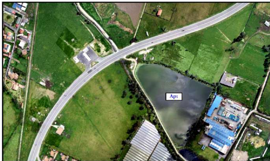
Ilustración 69. Planta de tratamiento de aguas residuales. Vereda Calahorra. (imagen tomada por medio de vuelo de dron por Arco Consultorías y Construcciones).
