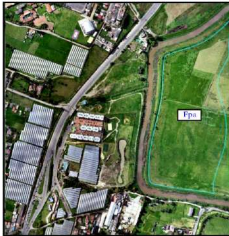
Ilustración 64. Plano anegadizo, en meandro del río Bogotá. (imagen tomada por medio de vuelo de dron por Arco Consultorías y Construcciones).
