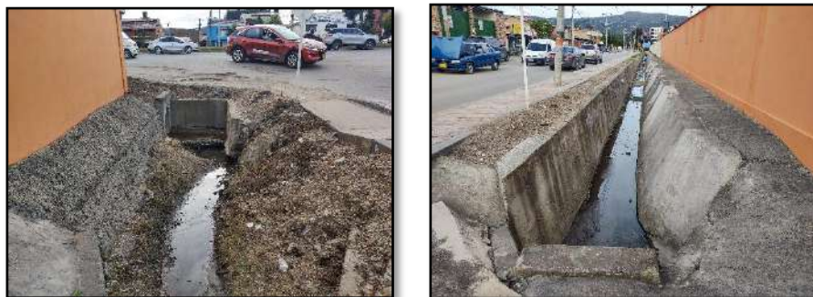
Ilustración 21. Levantamiento topobatómétrico y registro de dimensiones y perfiles de estructuras hidráulicas.
