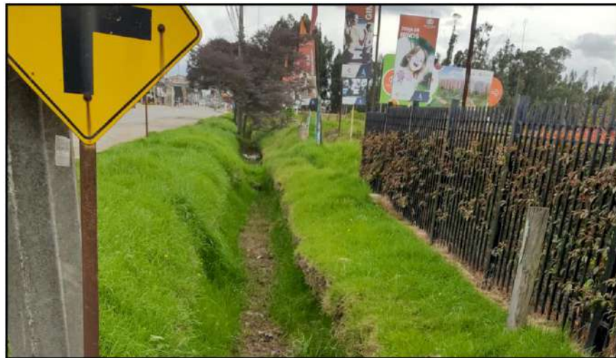
Ilustración 67. Canal Artificial en el área urbana de Cajicá. Fuente: Arco Consultorías y Construcciones Ltda. (2021).
