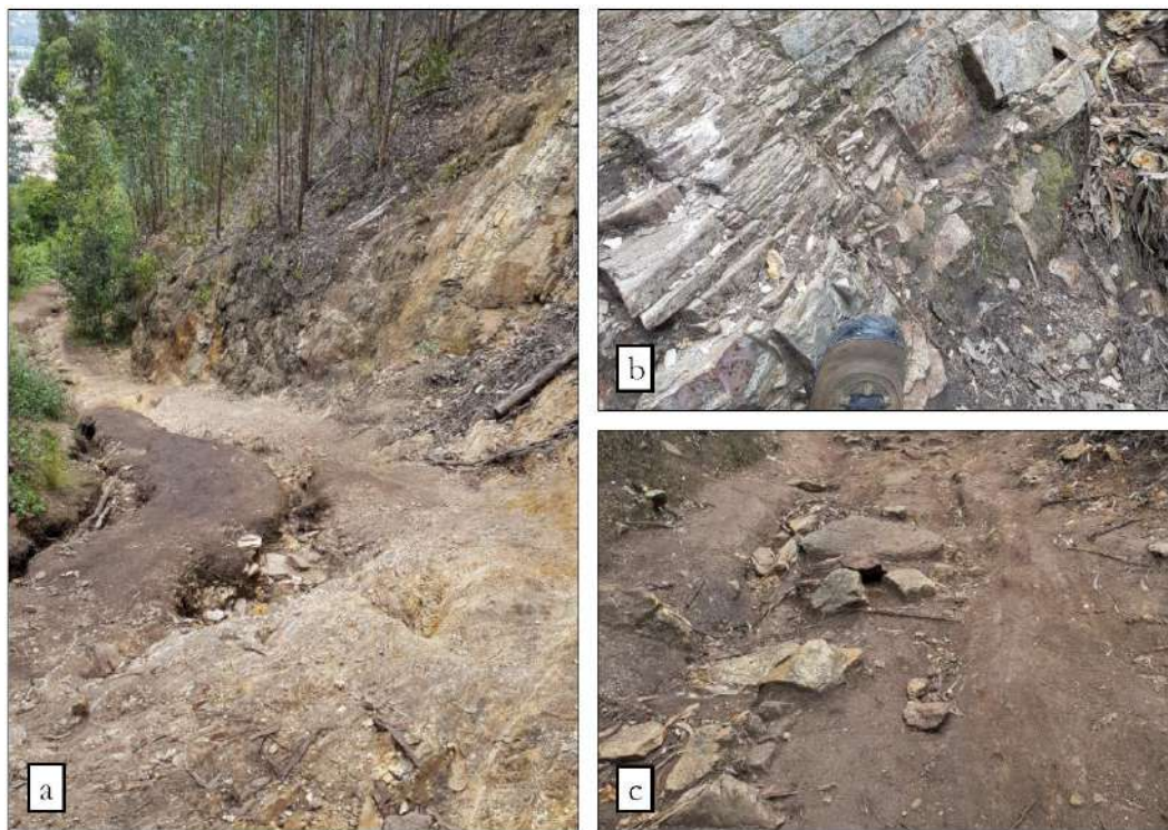
Ilustración 9. Movimiento en masa del tipo caída de roca, extremo sur occidental de la vereda Chuntame, a) macizo rocoso al borde de lo que parece ser un camino de herradura en mal estado, b) macizo rocoso diaclasado, pero competente, c) Fragmentos de roca caídos y que han sido embebidos dentro de una matriz de material fino, limoso y suelto, estación 072 (X: 4883431,31 Y: 2103804,71).
