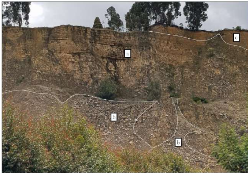
Ilustración 3. Cantera la Naveta al sur occidente del municipio, vía Manas-Molino, que muestra: roca, suelo y depósitos, en un mismo escenario, a) roca estratificada insitú, b) depósitos de tipo coluvión, c) Formación de suelo por acción de la meteorización, Estación 009 (X: 4887135,31 Y: 2105117.61).
