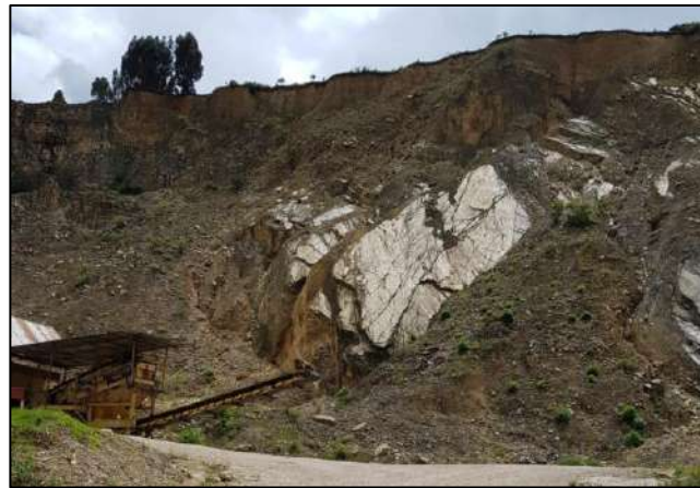
Ilustración 11. Deslizamiento en cuña en consecuencia la formación de coluviones en la Cantera de la Naveta, vía Manas-Molino, estación 009 (X: 4887135,31 Y: 2105117,61).
