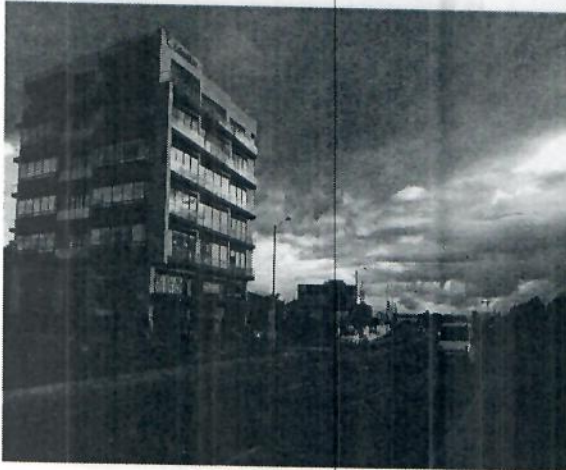
VISTA NORTE DEL INMUEBLE SOBRE CALZADA CAJICA-CHIA
