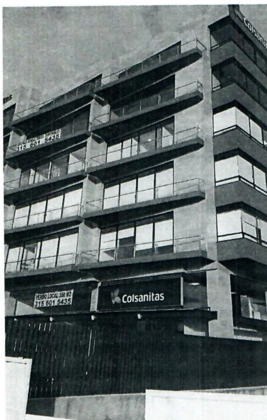
VISTA DE CERRAMIENTOS LATERALES DEL INMUEBLE.
