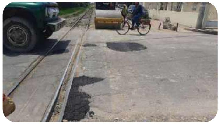
02-03-2020 Reparcho calle 7, material asfalto en frío suministrado por la EPC, utilizando volquetas, vibro compactador y retroexcavadora
