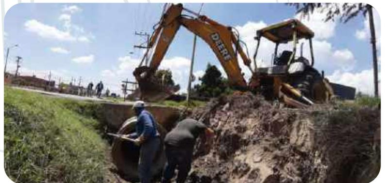
28-01-2020 se realizó la instalación de un tubo con box culvert de 36 pulgadas de diámetro, en entrada nueva a Capellanía, utilizando retroexcavadora y volquetas.
