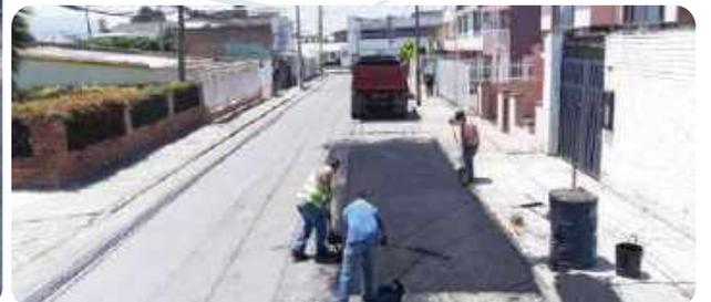
El 6 de marzo se realizaron varios frentes de trabajo para realizar reparcho en diferentes partes del municipio, para esto se utilizaron volquetas, vibro compactador y retroexcavadora
