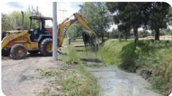
28-02-2020 limpieza de 1.200 metros de vallado en la vía la Mejorana utilizando retroexcavadora y volquetas
