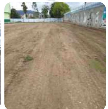
20-01-2020 nivelación cancha de 1.500 mts2 colegio San Gabriel, utilizando vibrocompactador, volquetas, retroexcavadora y vibro compactador para nivelar la tierra traída del Politécnico
