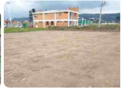
24 al 30 de enero 2020 nivelación cancha alterna de 2.100 mts<sup>2</sup> en el colegio Antonio Nariño, utilizando vibrocompactador, volquetas, retroexcavadora y vibro compactador para nivelar la tierra traída del Politécnico.
