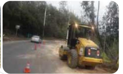
18 al 30 de enero se realizó limpieza de la alameda vía Tabio desde la Alquería hasta Golpe de Agua, en compañía de la EPC utilizando volqueta y retroexcavadora para recoger escombros y vibrocompactador para nivelar la vía
