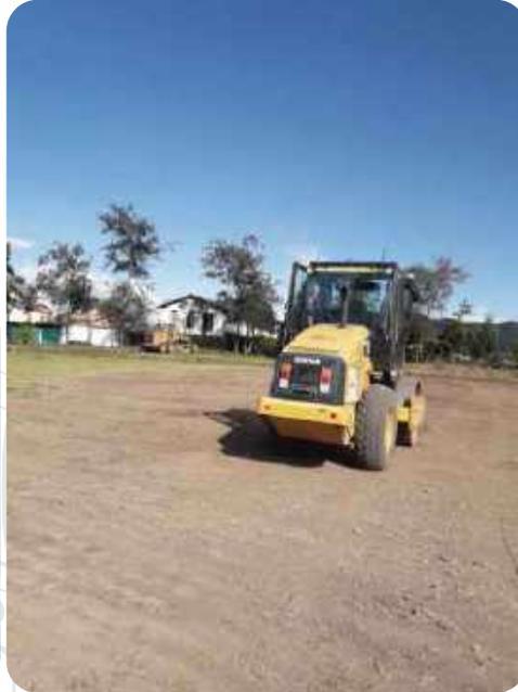
31-01-2020 al 07-02-2020 se realizó la adecuación lote en el sector el Misterio para realizar un campo deportivo, utilizando retroexcavadora para 7.000 mts, utilizando volqueta para riego, vibrocompactador para nivelación
