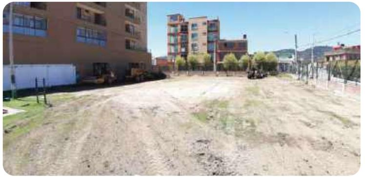
11-02-2020 nivelación cancha del sector el Rocio, utilizando tierra del Politécnico, motoniveladora, vibrocompactador y volquetas
