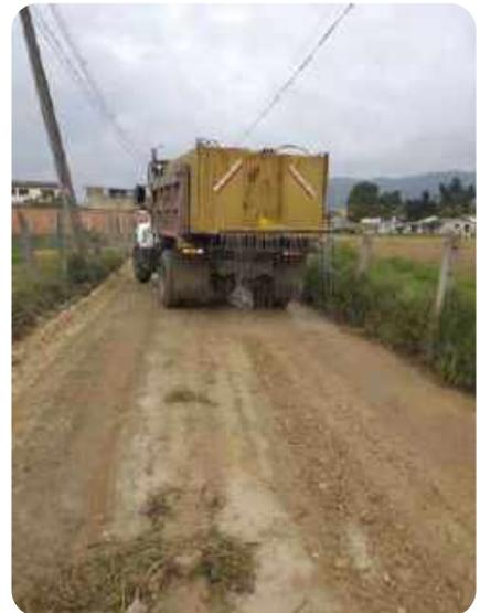
Del 18 al 22 de enero 2020 se trabajó en la humectación vía en Gacho, el camino de San Pedro en Canelón y calle 8, utilizando volqueta y tanque de agua
